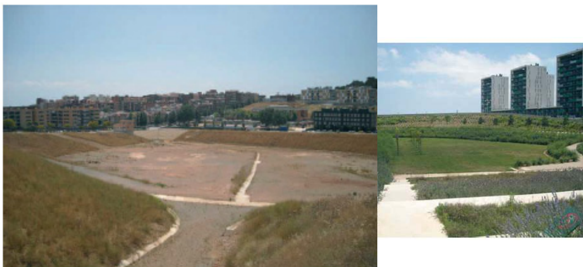
Figura 19. Ejemplo de balsas de laminación controlada.
